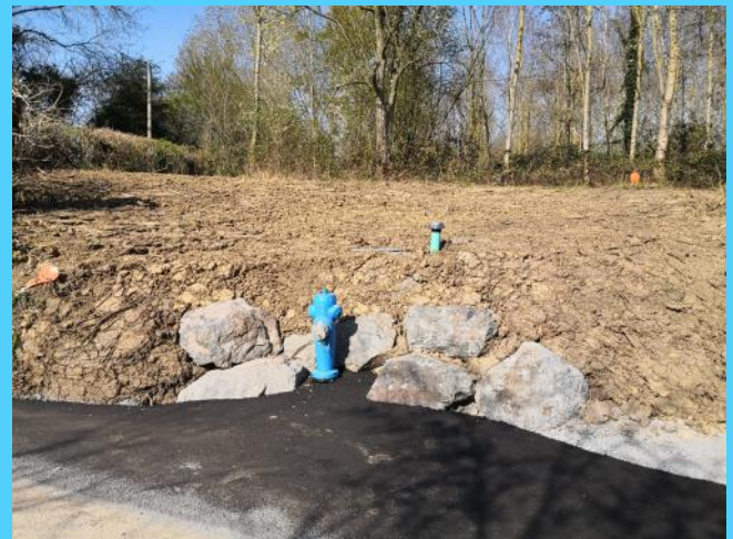
Réalisation d'une citerne incendie bas du chemin de Saint Aubin.
