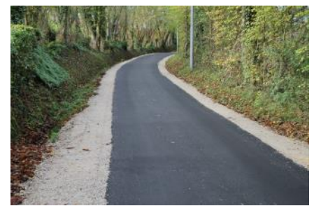
Restructuration et stabilisation du chemin de Saint Aubin.
