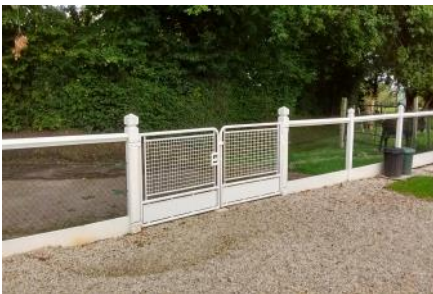
Mise en peinture des portes des 3 cimetières
