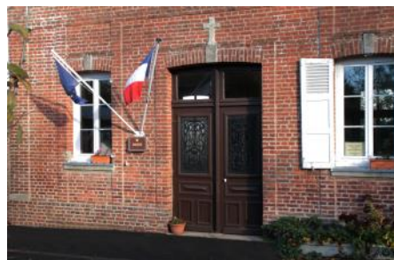
Réparation de la porte de la mairie annexe de St Aubin Lebizay
