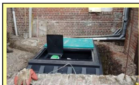
Mise aux normes de l'assainissement de la Mairie de Saint Aubin Lebizay. Installation d'une Micro-station d'épuration.
