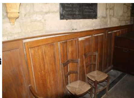
Réfection des boiseries de l'église de Beaufour et protection du clocher des pigeons.
